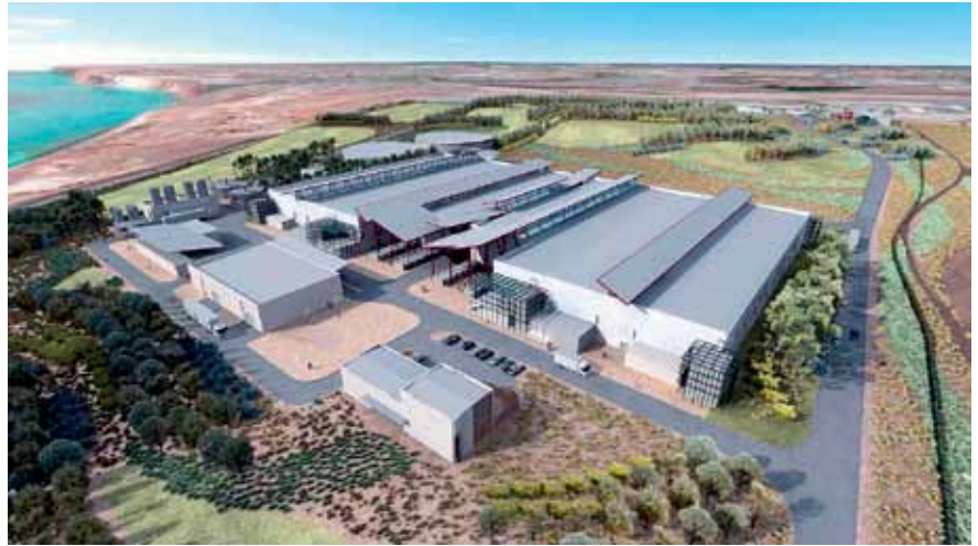
Planta desaladora de Port Stanvac. Adelaida. Australia.
